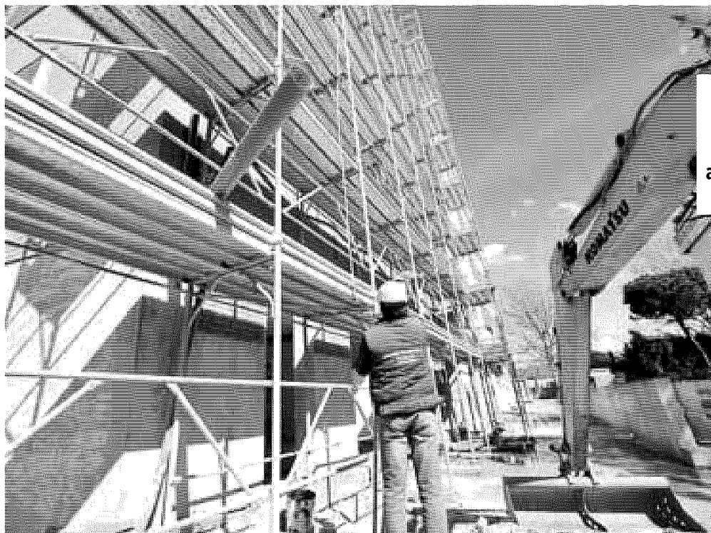
Un cantiere edile per la realizzazione di civili abitazioni
